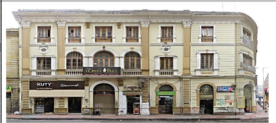
Fuente: Equipo Fotografía PEMP Patrimonio Inmueble
